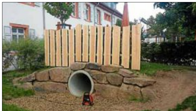
Neue Brüstung über der Kriechröhre im Kindergarten Mühlhausen.
