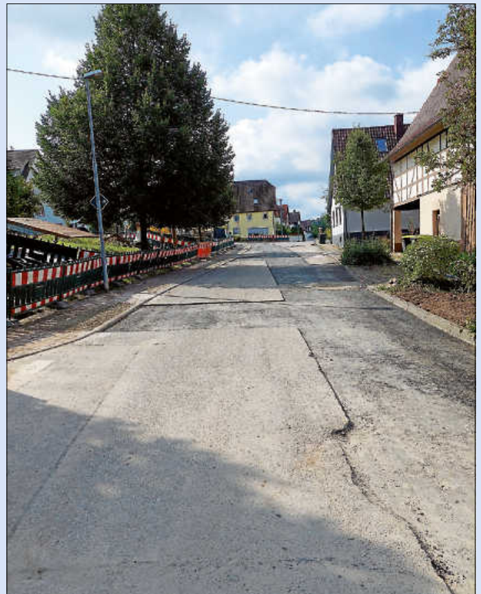
Würmtalstraße Baustelle zwischen Mittelstraße und Tiefenbronner Straße Foto: Gemeinde Tiefenbronn
