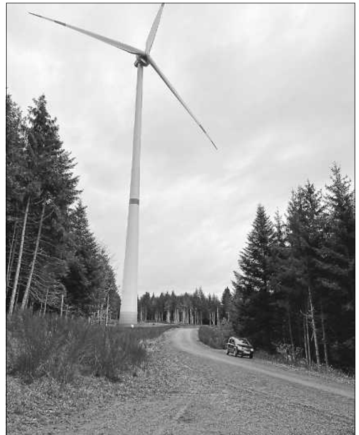
Transportschneise für den Bau einer Windkraftanlage im Schwarzwald. Foto: R. Bommer
